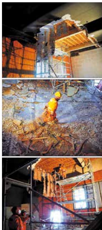
Le chantier de la Grange Delux. Une métamorphose spectaculaire. (Photos: Catherine Meier)
