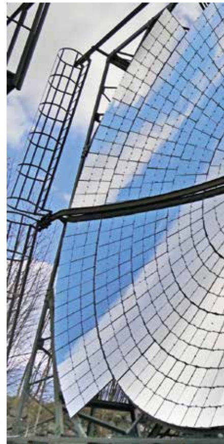
C'est en raison d'un ensoleillement idéal, que miroirs permettant d'alimenter le four solaire
