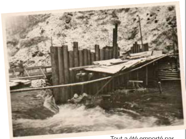
Tout a été emporté par les flots... sauf les palplanches. (Photo jpm)
